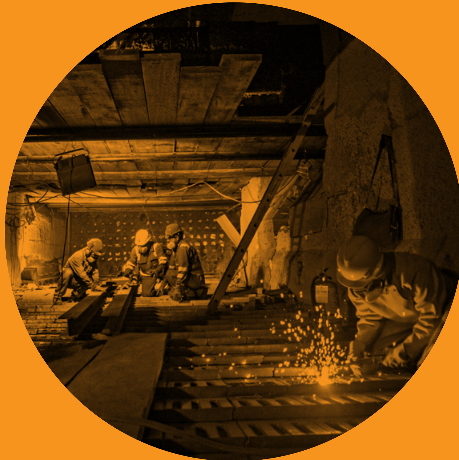
Mantenimiento y reparación refractaria anual del horno 2, planta Atocongo. Villa María del Triunfo, Lima, Perú.
