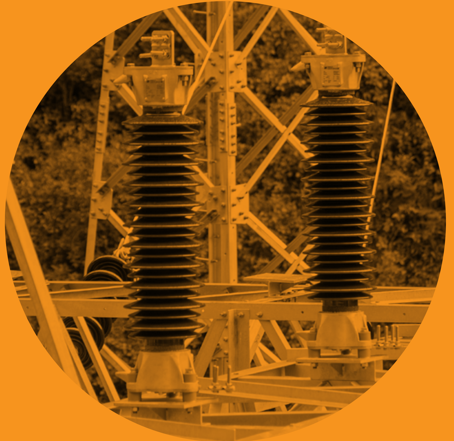
Proyecto Central Hidroeléctrica Carpapata III. Tarma, Junín, Perú.
